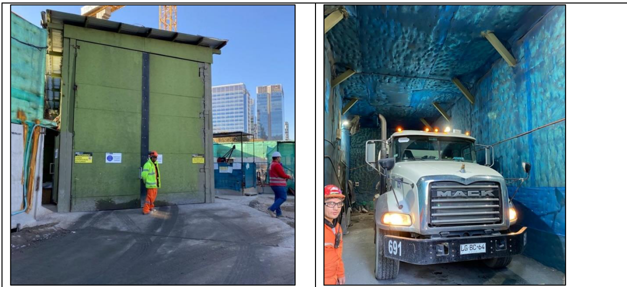
Figura 11: Imagen referencial de túnel acústico de hormigonado.
