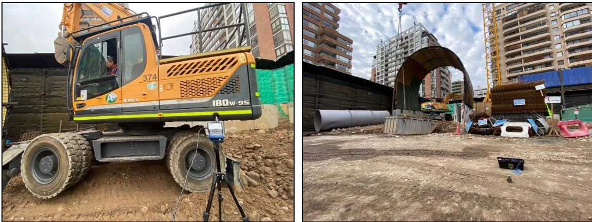
Figura 20: Excavadora de neumáticos en pique Vitacura Línea 7 de Metro.
