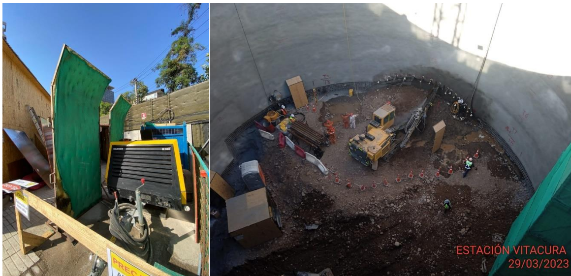
Figura 14: Imagen referencial de barrera móvil y encierro de compresor implementado en obras de Metro.
