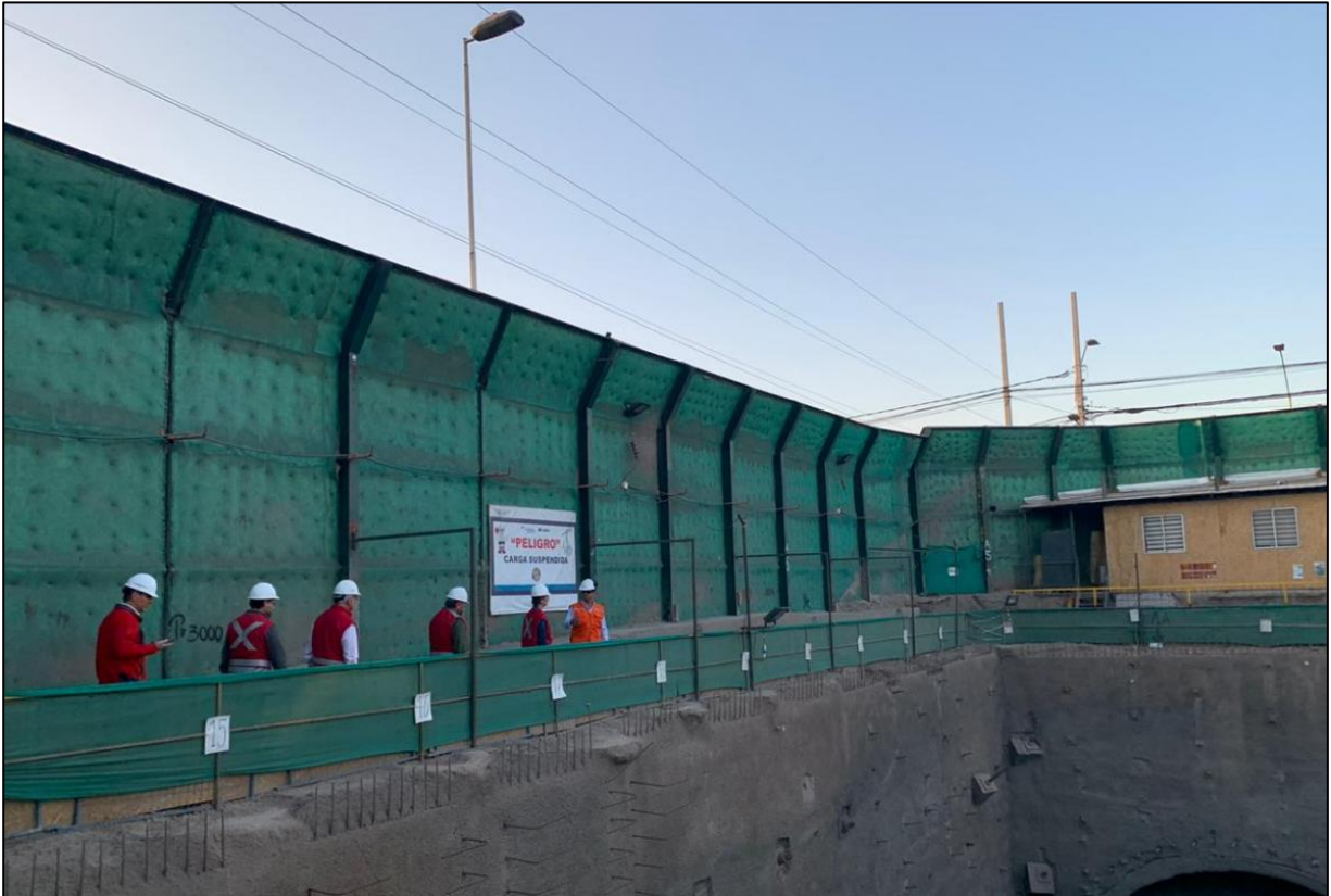
Figura 9: Cierre perimetral en instalación de faenas de obra de Metro Extensión Línea 3.
