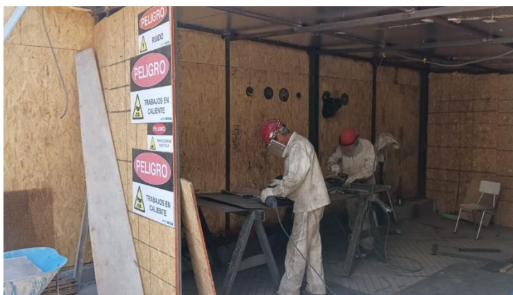
Figura 15: Imagen referencial de taller de corte implementado en obras de Metro.
