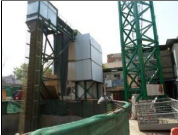
Figura 18: Cierre de Cinta Transportadora Pique Hernán Cortés – Línea 6 de Metro
