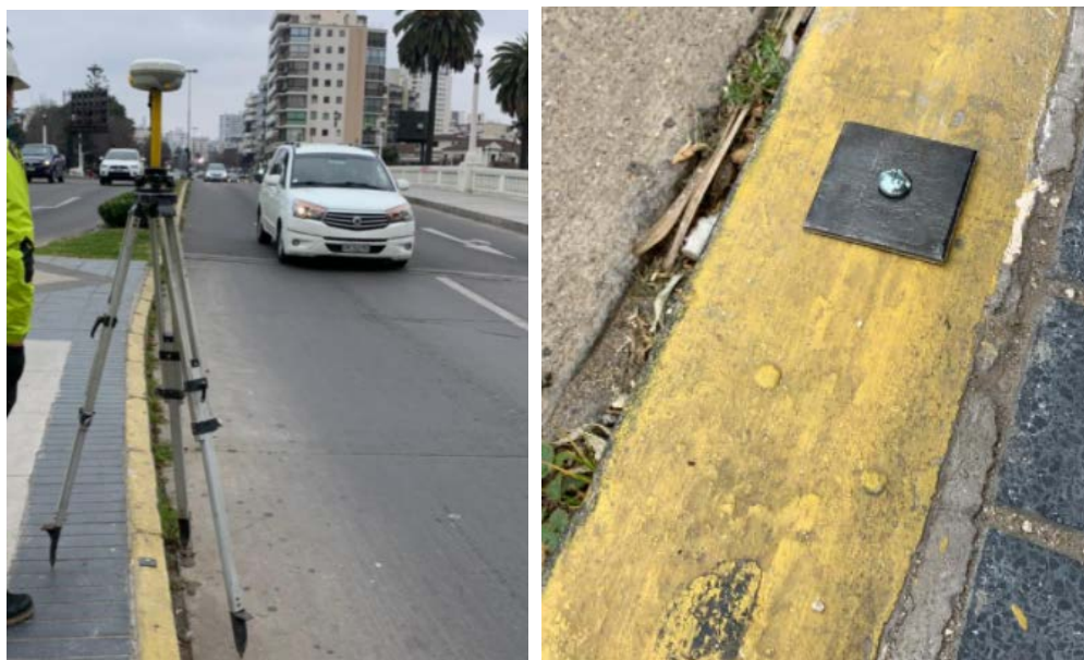
Figura 4.3 Materialización red primaria estudio topográfico
