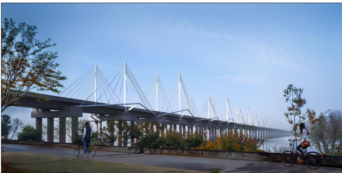
Figura N° 6. Vista del nuevo puente desde Av. Costanera hacia San Pedro de la Paz.
