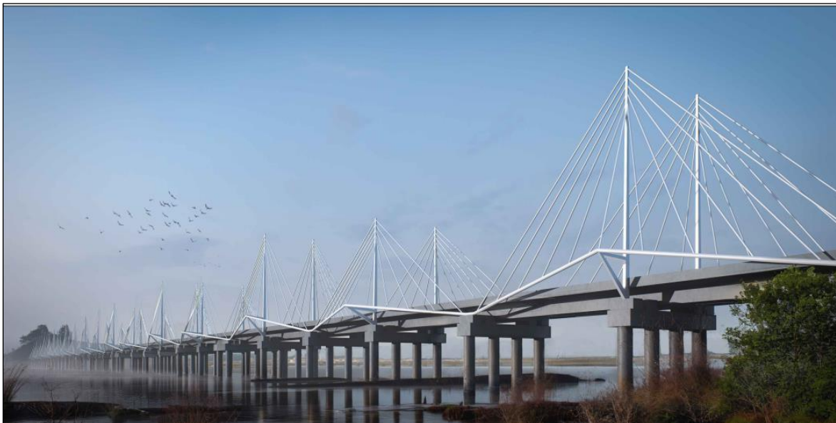
Figura N° 5. Vista del nuevo puente dirección desde rivera San Pedro de la Paz hacia Concepción.
