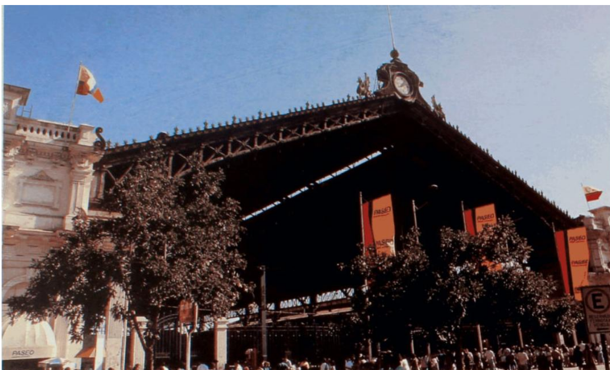
Ilustración 5: Fachada principal, estructura metálica de nave central.
