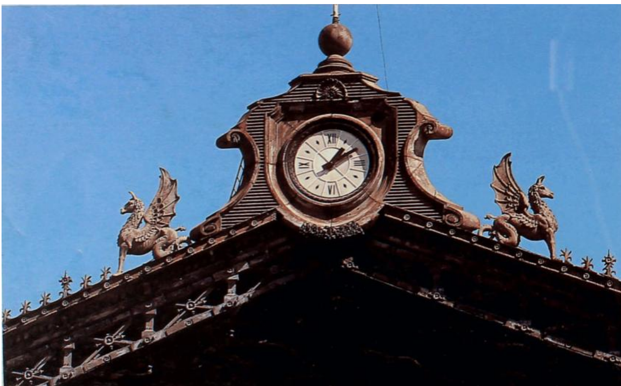
Ilustración 6: Coronación superior de estructura metálica de nave central.
