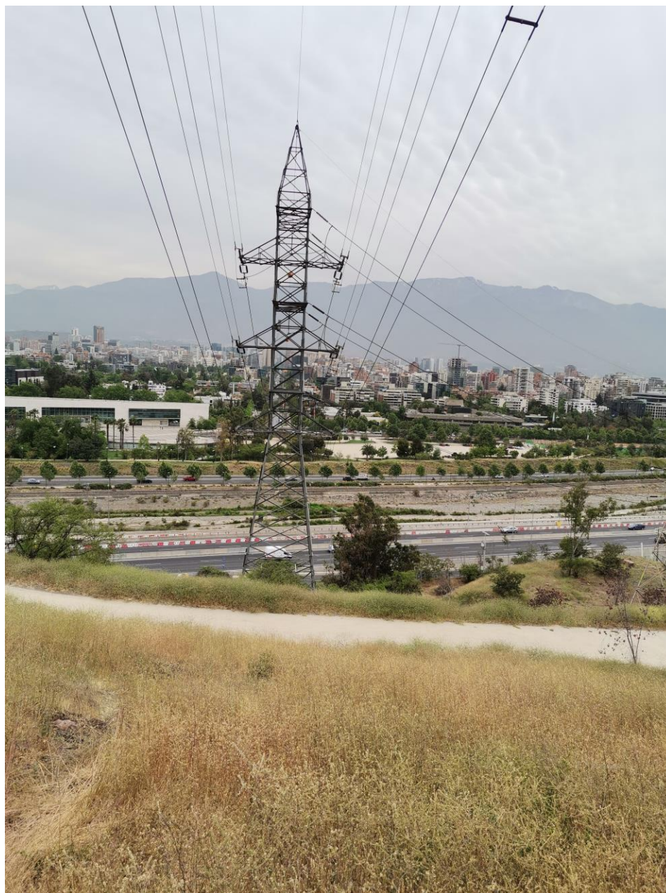
Fotografía 1. Torre actual en LAT 110 kV Los Almendros - El Salto
