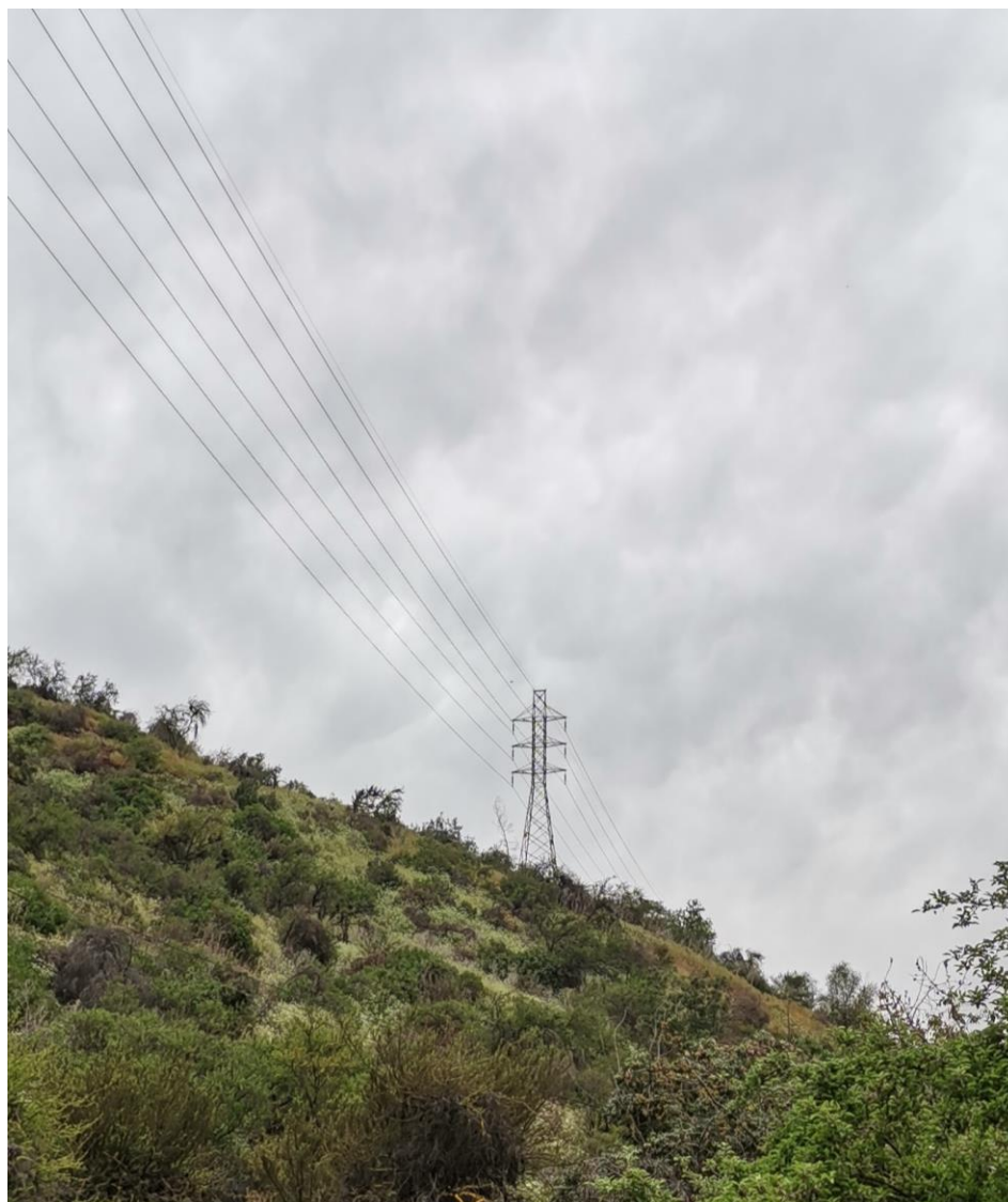
Fotografía 3. Torre actual en LAT 110 kV Los Almendros - El Salto
