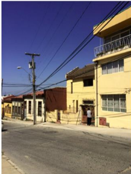
Imagen N° 1. Vivienda a demoler, calle Pedro León Gallo.
