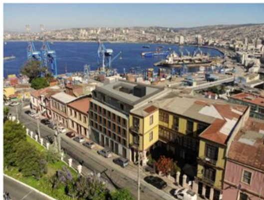
Imagen N°4. Nuevo edificio, completa la volumetría de la fachada existente de la cuadra.
