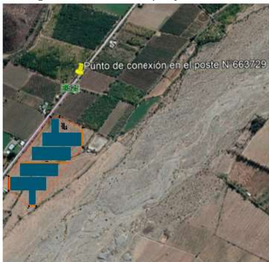
Imagen 1: Obras del proyecto fotovoltaico.
