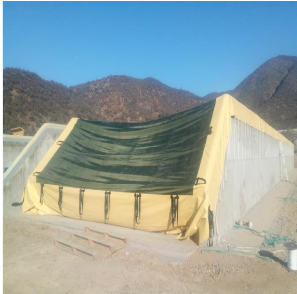
Figura N°1. Trinchera en Plantel Valdebenito
