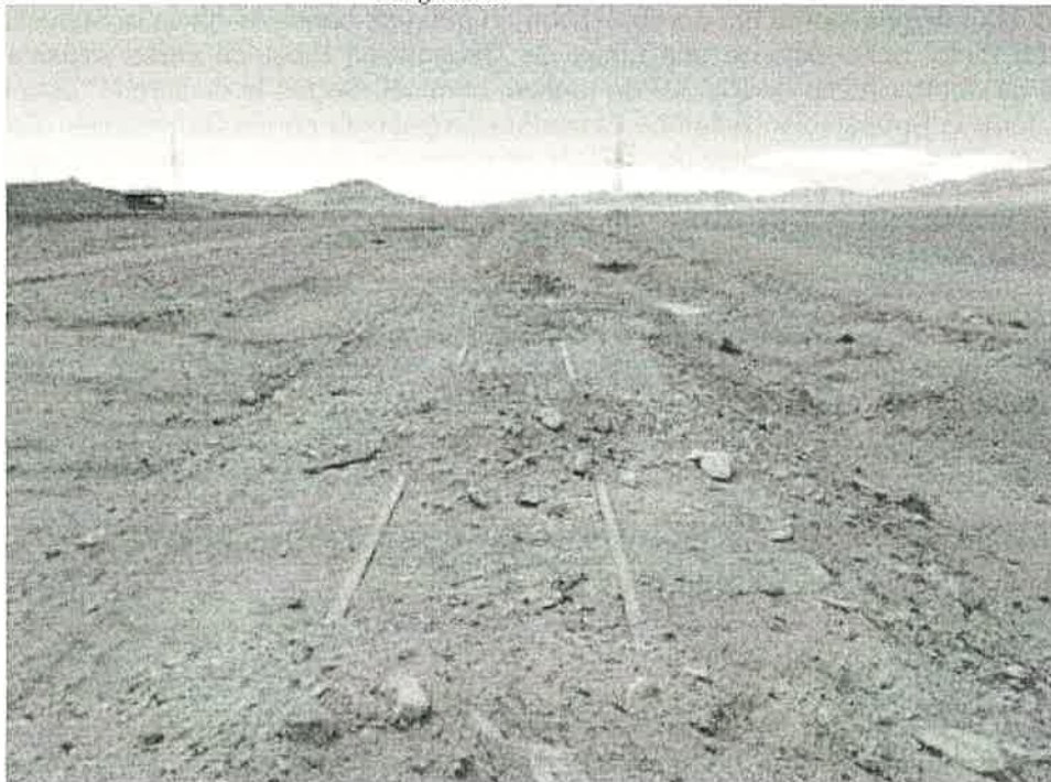
Figura 4 Condiciones Actuales Ferrocarril Longitudinal Norte
