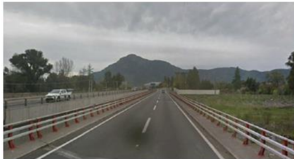
Fotografía N°1. Actual Puente Peuco para reemplazar
