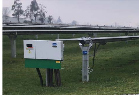
FIGURA 4: Disposición de Inversores – Foto PFV Las Turcas.
